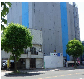
RC造 地上15F 52戸マンション
