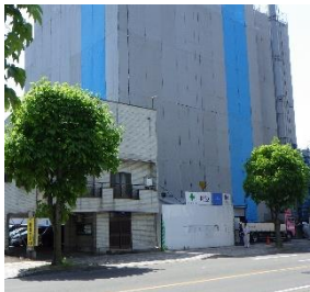
RC造 地上15F 52戸マンション
